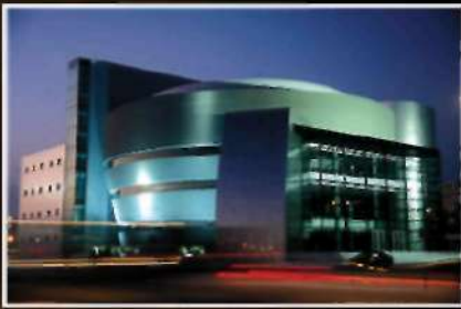
AUDITORIUM OF ROQUETAS DE MAR
